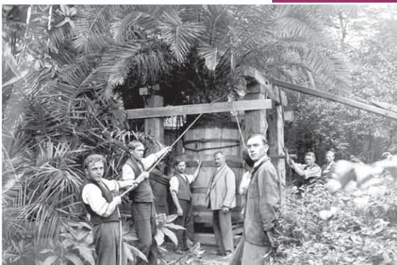
Prace w Starej Palmiarni, około 1930 r.
